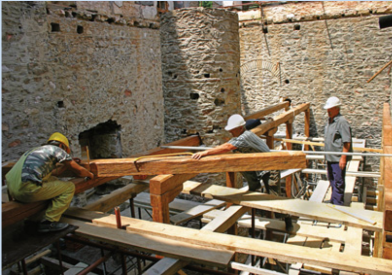
Hilandar's construction workers on the construction site Радници манастирске грађевинске радне групе обнављају конаке
