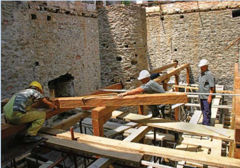
Рабочие монастырской строительной группы обновляют корпус Радници манастирске грађевинске радне групе обнављају конাকে
