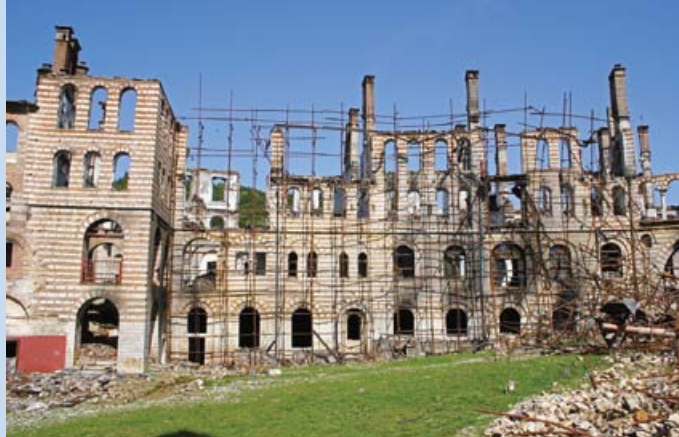
Большой корпус после пожара Велики конак, после пожара
