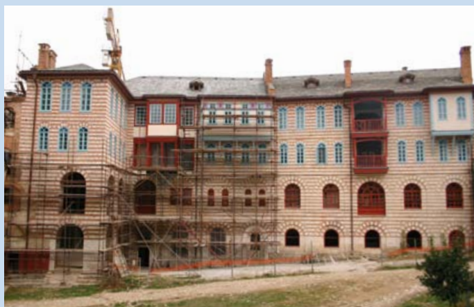
Большой корпус во время проведения работ по обновлению, декабрь 2011. Велики конак, у току обнове, децембар 2011.
