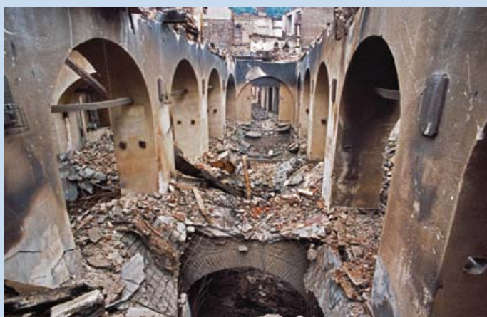
Большой корпус, Странноприимница, после пожара Велики конак, Странопријемница, после пожара
